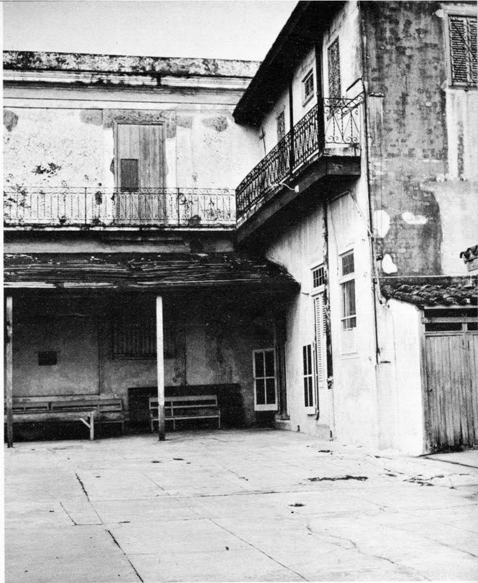
EN ESTE PATIO ESTABA EL CEMENTERIO
