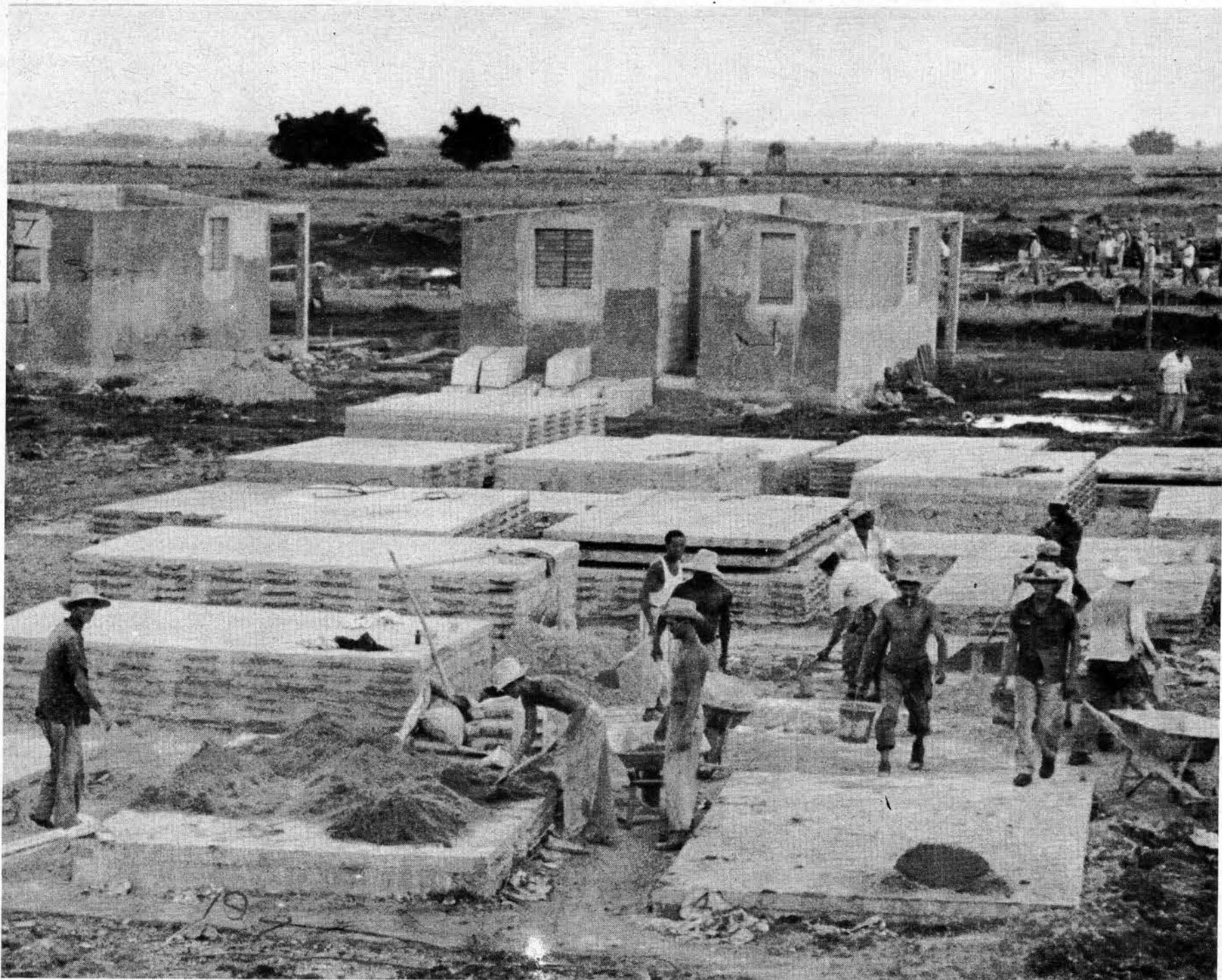
Paredes y techos de concreto se funden en serie para ser colocados rápidamente por medio de grúas poderosas.
